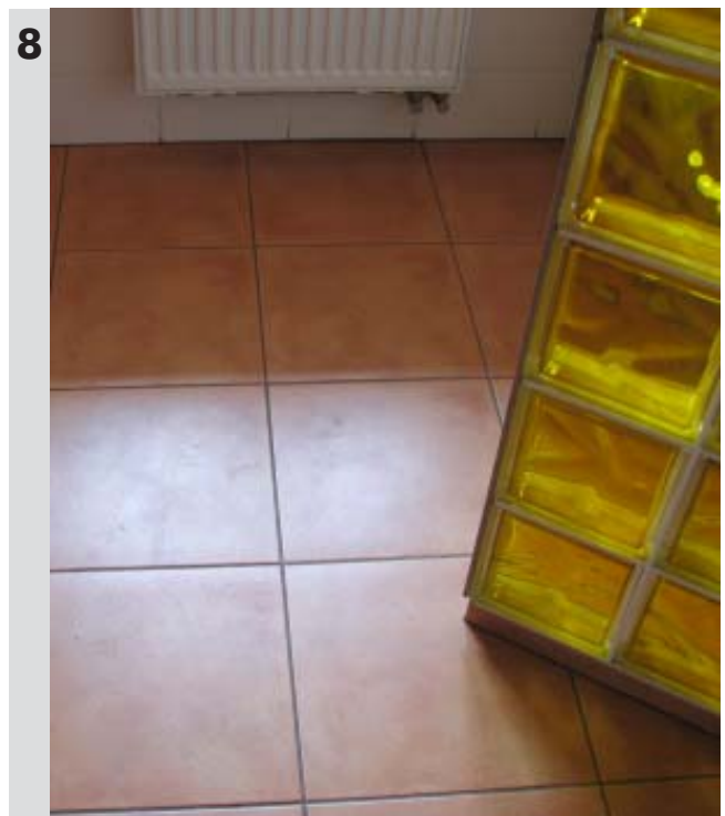
Wylanie posadzki min 5cm i przyklejenie płytek ceramicznych
