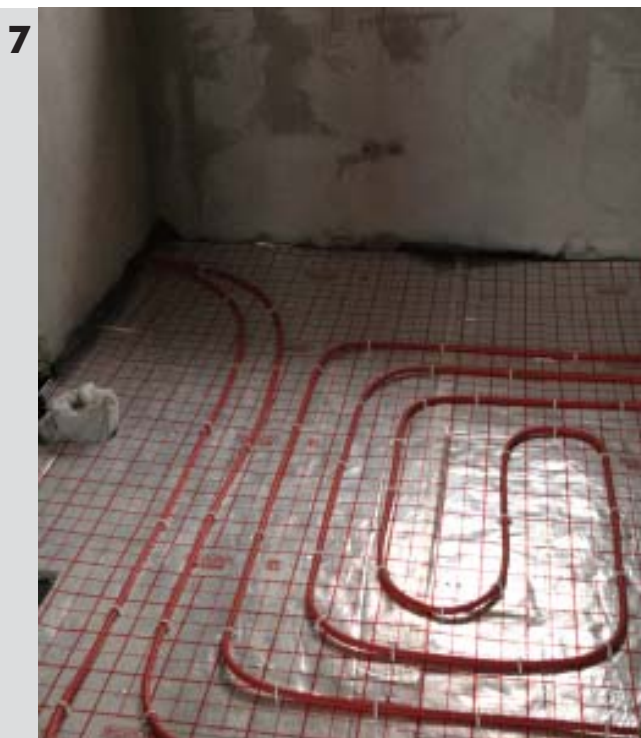
Rozwinięcie instalacji grzewczej
