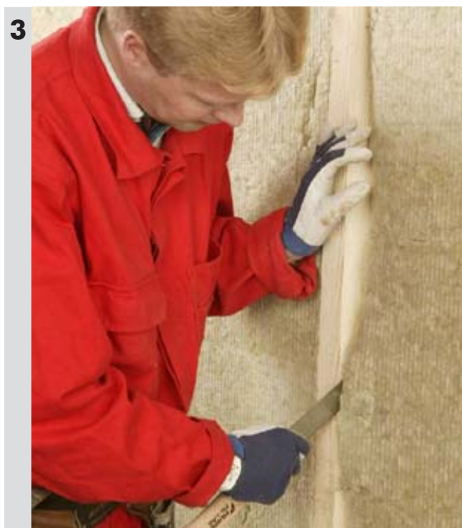
wyrównywanie krawędzi płyt
