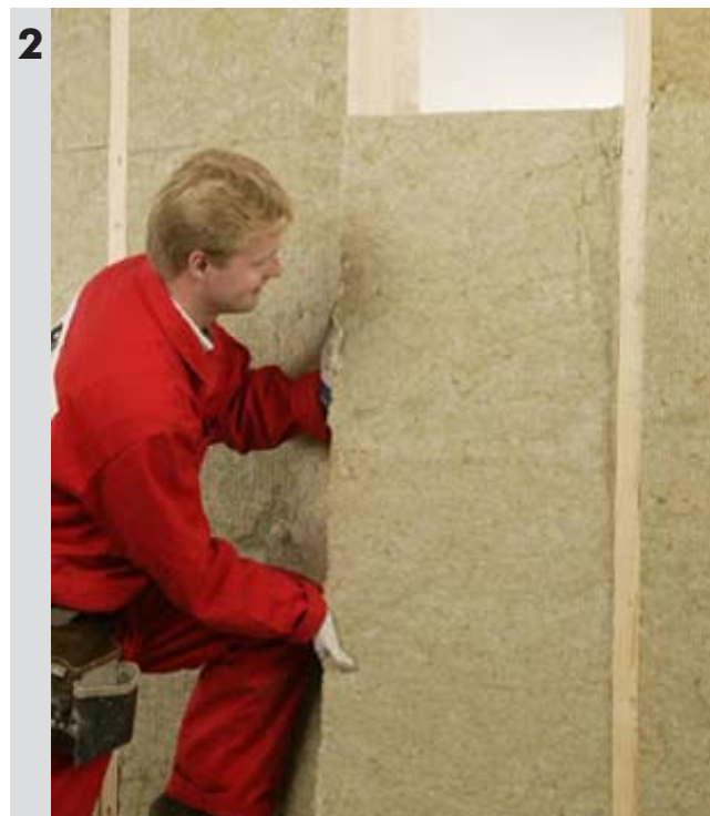
montaż płyt w szkieletcie ściany
