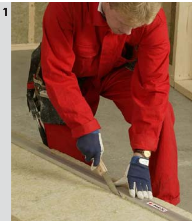
cięcie płyt PAROC do odpowiedniego wymiaru
