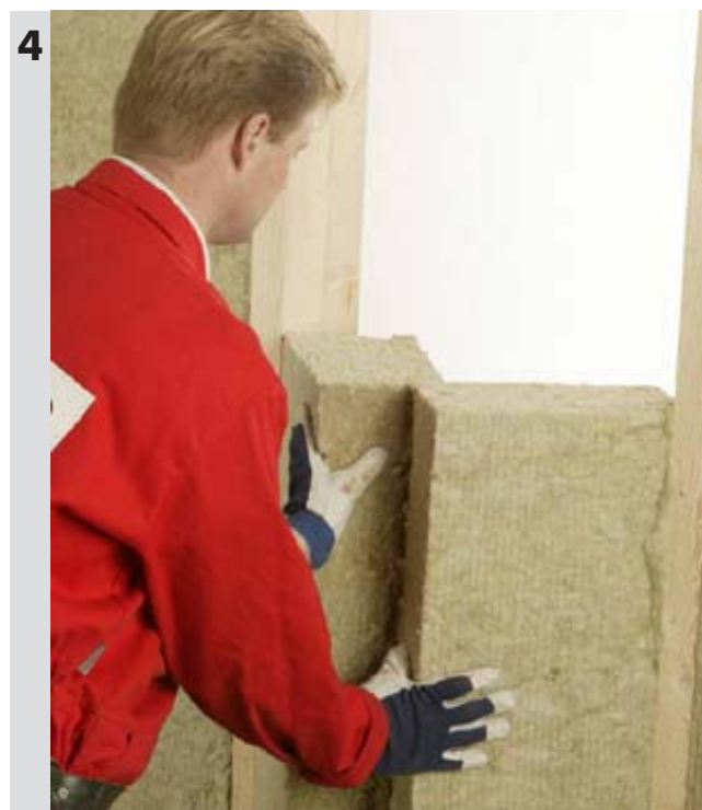
montaż izolacji z dwóch płyt
