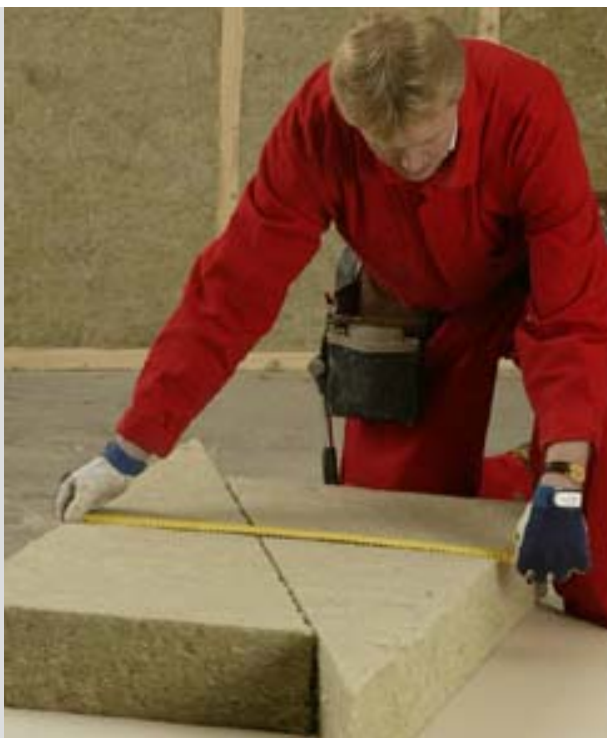
wykorzystanie odpadów poprzez układanie izolacji z trójkątów
