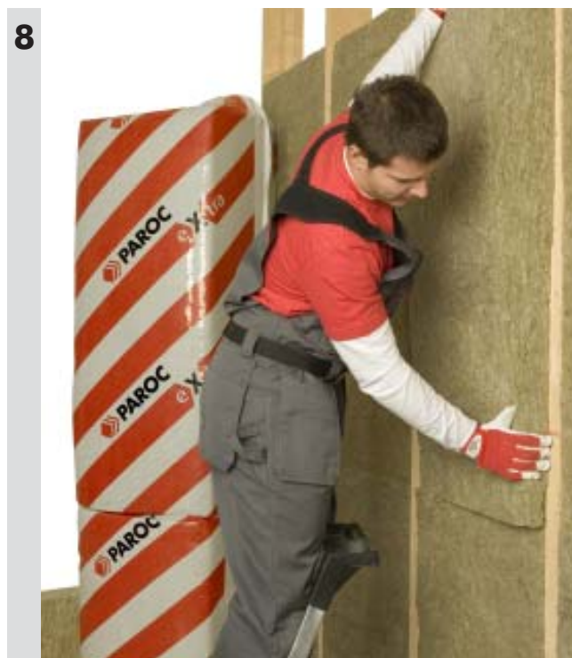
Montaż drugiej warstwy płyt
