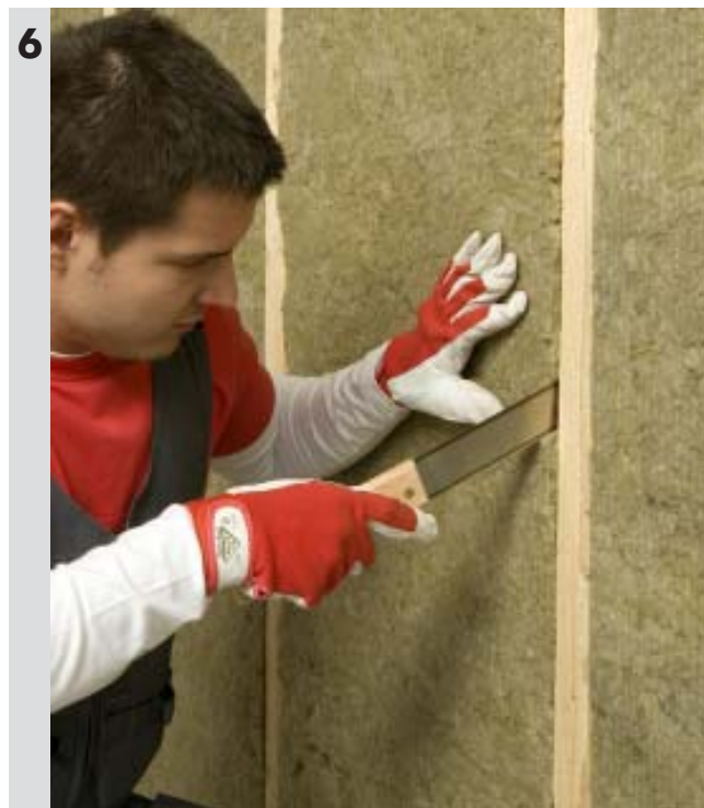
Dopasowanie krawędzi nożem
