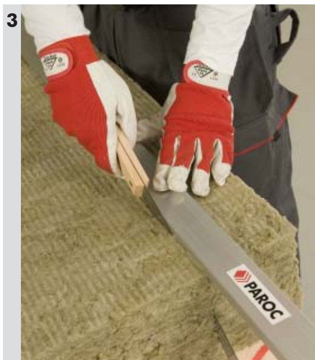
Cięcie płyty do wymiarów szkieletu - należy pamiętać o dodaniu 1 cm więcej
