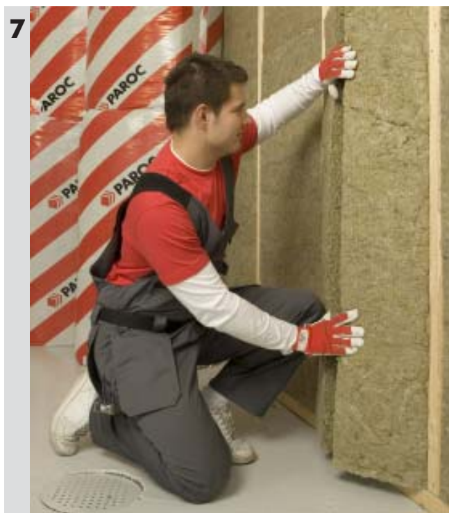
Montaż z kawałków płyt
