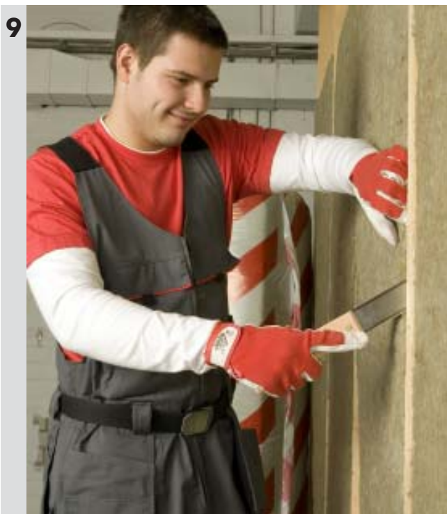
Dopasowanie krawędzi nożem
