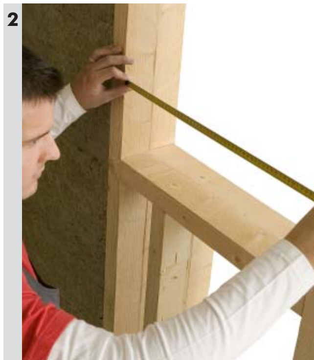
Zwymiarowanie profili
